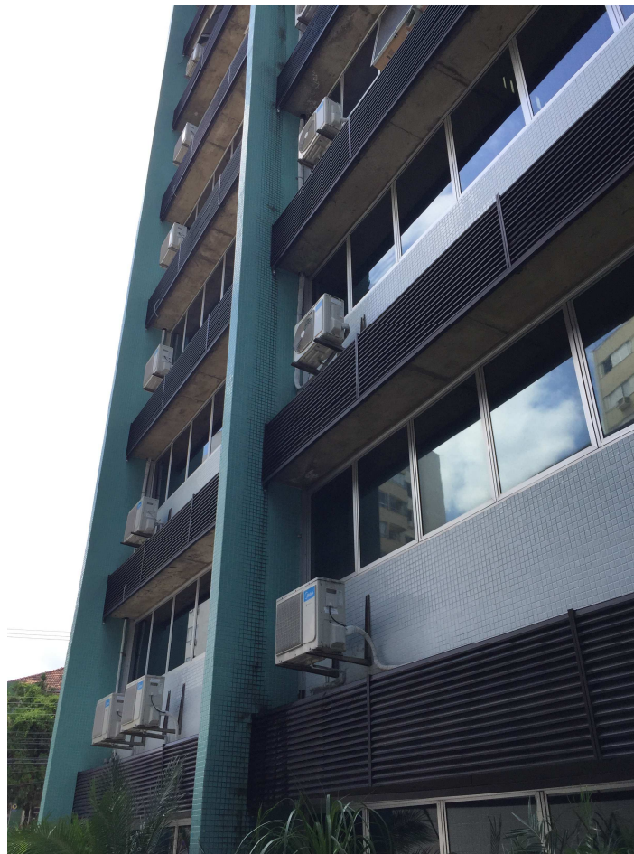
Imagem 02 – Vista dos gradis metálicos que serão retirados
